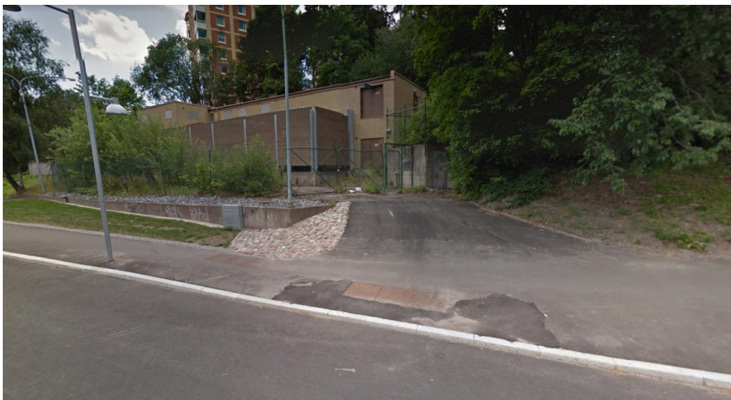
Figur 3. Befintlig lokalnätstation med Galoppvägen i förgrunden. Kulvertentrén syns på höger sida om uppfarten (Google Maps 2019-02-05).
