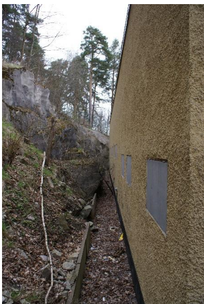
Figur 4. Nätstationens baksida med sluttande skogsmark i väst (bild Vattenfall)
