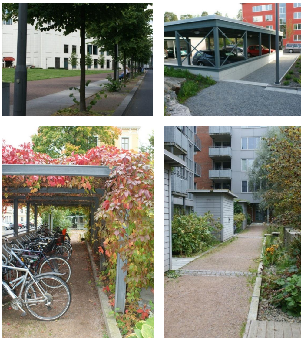
Figur 17. Exempel på permeabla beläggningar i Berlin, Stockholm och Oslo.
