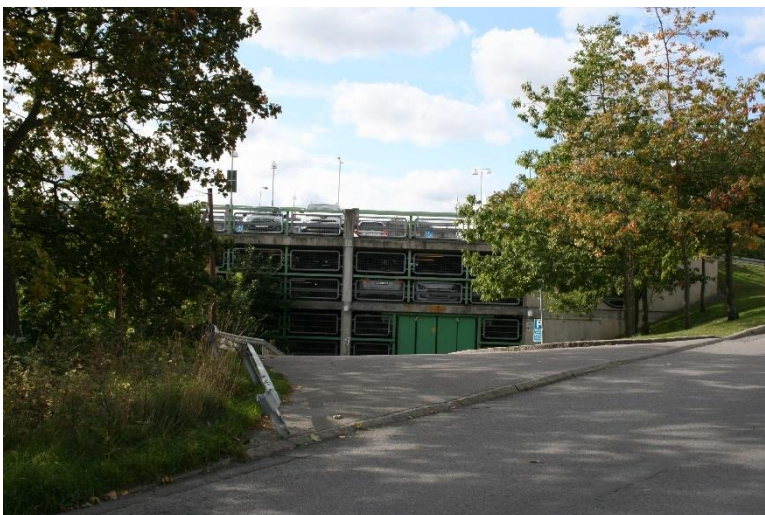
Vy 8) Befintlig in- /utfart sedd från Bockholmsvägen.
