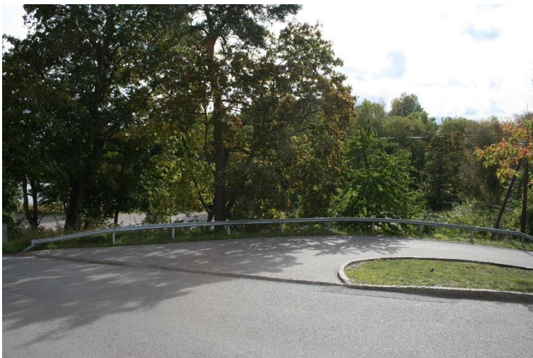
Vy 7) Befintlig in- /utfart sedd från Bockholmsvägen.
