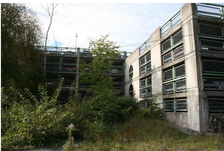
Vy 3) Befintligt parkeringshus.
