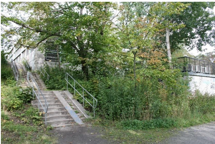
Vy 4) Befintlig trappa väster om parkeringshus.
