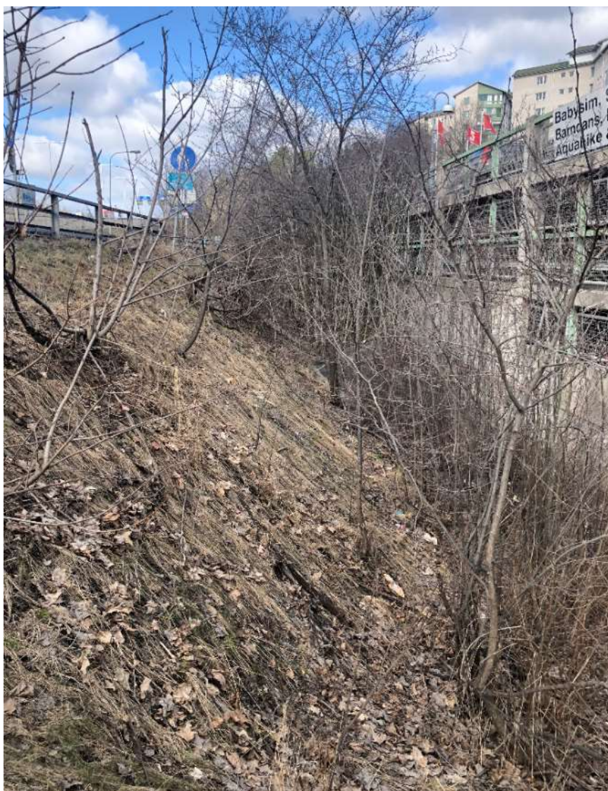
Figur 6. Befintlig slänt mellan Roslagsvägen och parkeringshuset.
