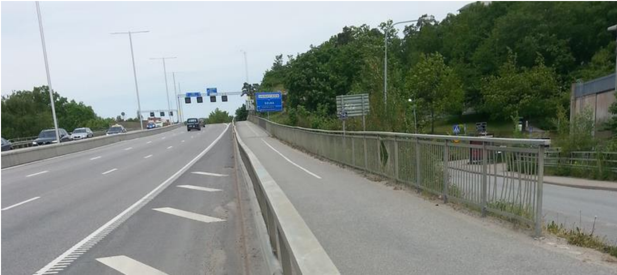
Figur 5. Roslagsvägens norrgående körbana med intilliggande cykelbana, och till höger i bild avtagsvägen mot Bergshamra och Bockholmen.
