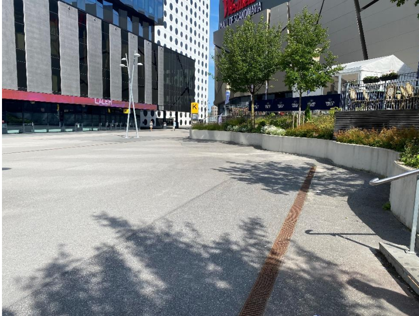
Bild 1. Ytan till höger illustrerar terrassen där uteserveringen är belägen.
