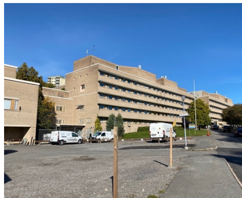
Figur 15. Kontorshygnaden sett från Ekelundsvägen. (Iterio, 2021)
