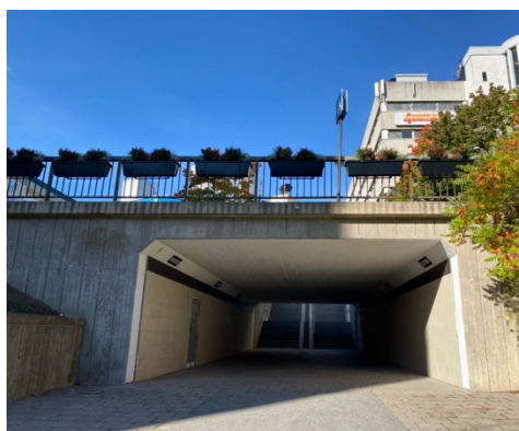
Figur 5. Gång- och cykeltunnel mot Västra Skogens centrum och tunnelbanestation. (Iterio, 2021)
