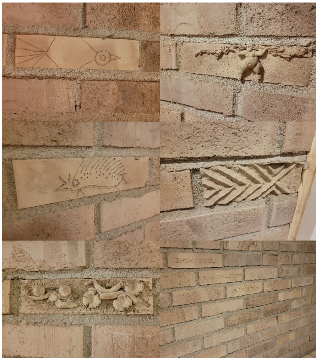
Några exempel på de bearbetade tegelstenarna i entrézon.
