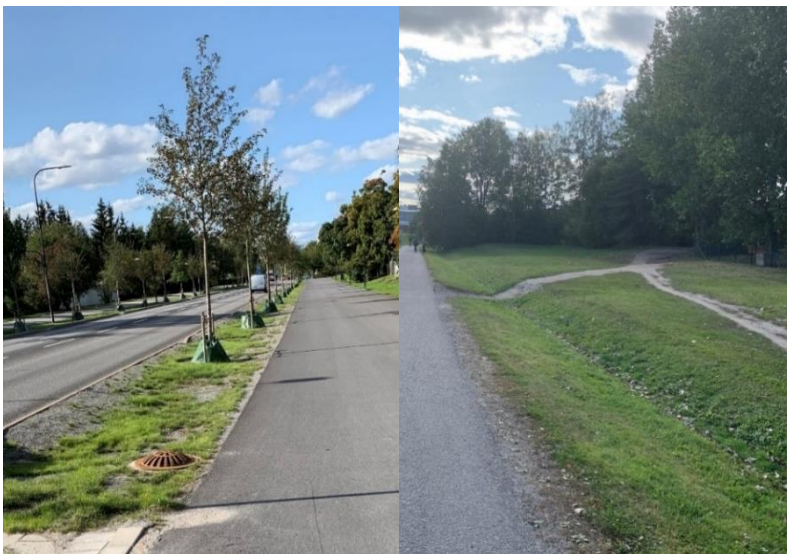
Figur 17. Exempel på infiltrationsstråk (foto Bjerking).
