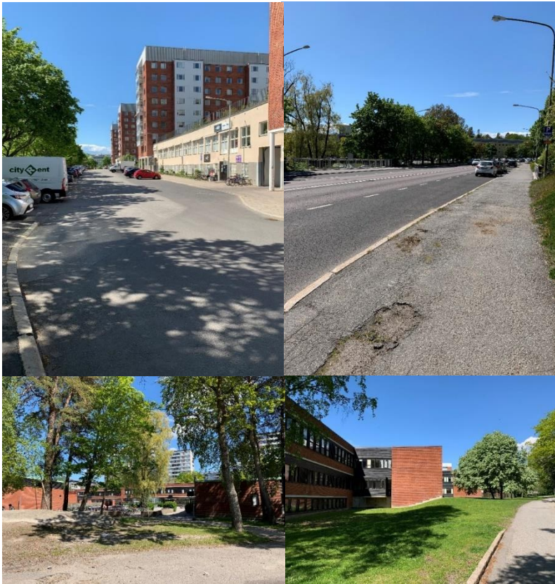
Figur 6. Foton från platsbesök 2020-05-26. Övre t.v. visar Krysshammarvägen, övre t.h. visar Armégatan och nedre visar delar av skolområdet.
