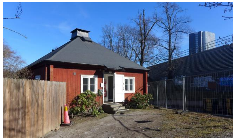
Figur 21. Det f.d. linneförrådet som ska flyttas för att ge plats åt den nya hotell- och konferensbyggnaden (AIX, 2016).
