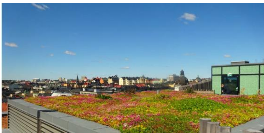
Figur 11. Sveavägen 44, grönt sedumtak med pimpstensjord med en tjocklek på 8–10 cm. Bild från Bara Mineralers presentation för WSP, 2016.
