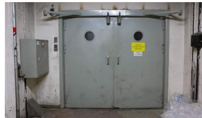
Bv. Ursprungliga stålportar till transporthiss.
