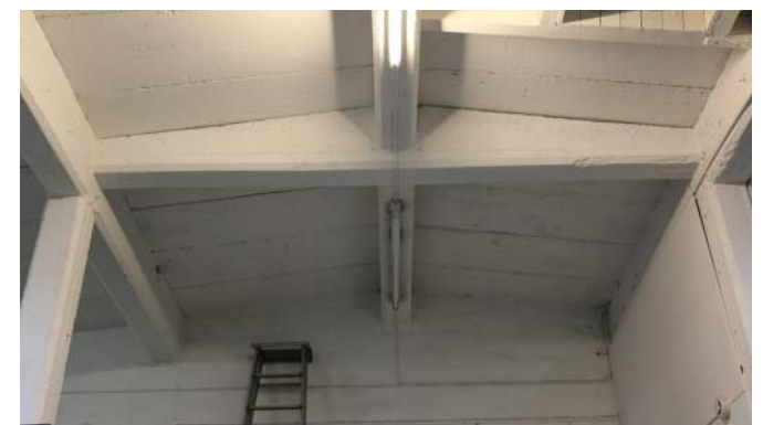
Tak med synliga betongbjälklag i våning 1 tr.
