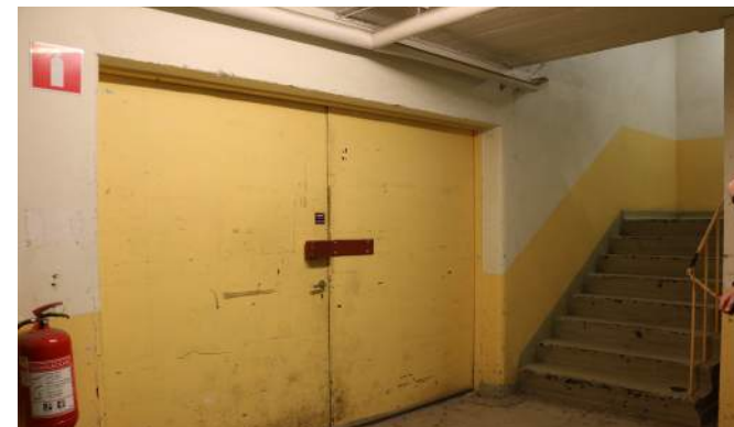
Ursprungliga stålportar i trapphus.
