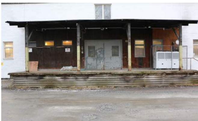
Ursprungliga stålportar vid lastbrygga mot öster.
