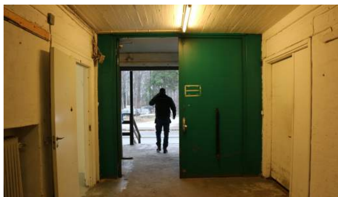
Mittgång i bottenvåning mot lastbryggan.
