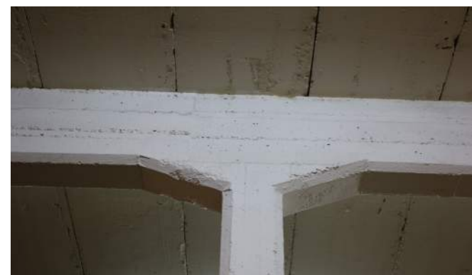
Synliga bjälklag och pelare av betong i våning 1 tr.
