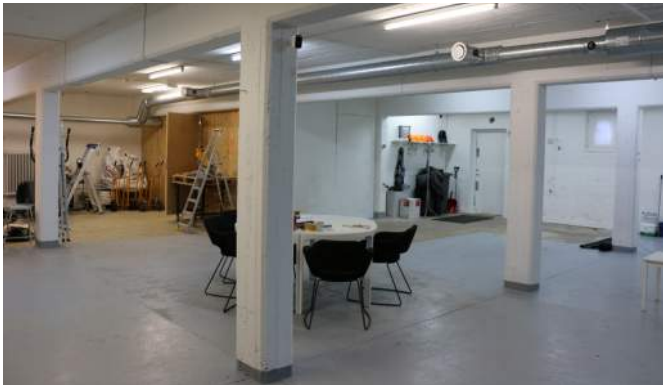
Källare. Delvis ursprunglig öppen plan med betongpelare.
