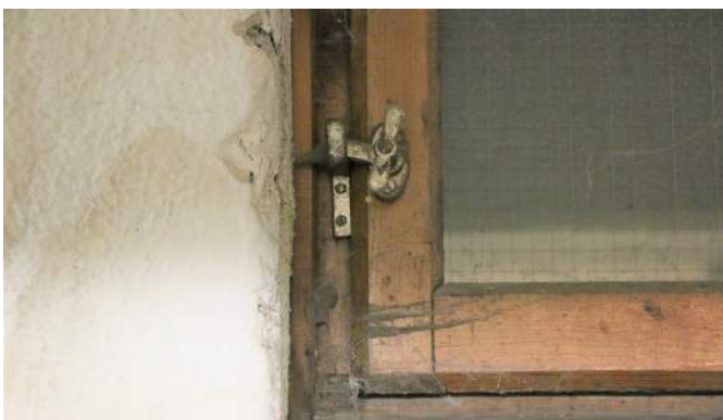
Fönster bevarar ursprungliga tidtypiska fönstervred.
