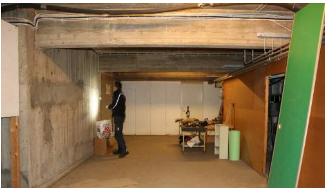
Källare med gjutna golv, väggar och tak.
