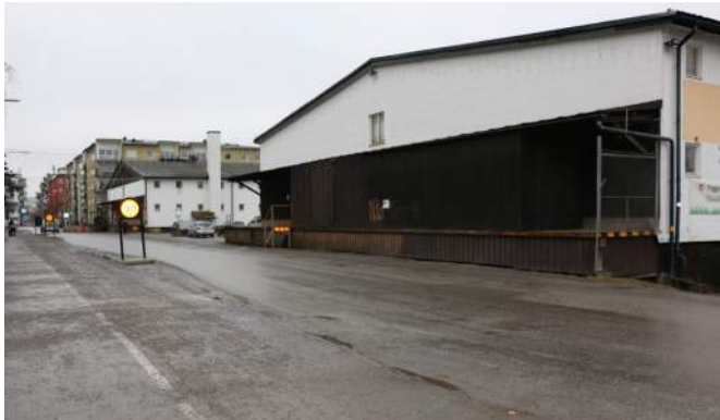
Hus E's lastbrygga mot Fridensborgsvägen.
