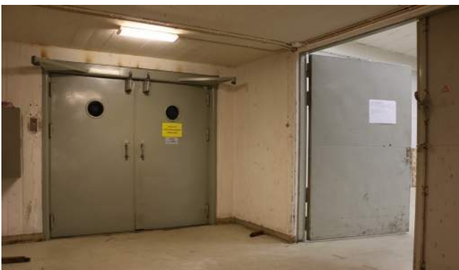
Ursprungliga stålportar till transporthiss.
