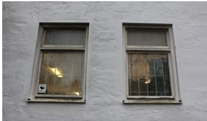
Ursprungliga fönster med tvärpost i gavlar.
