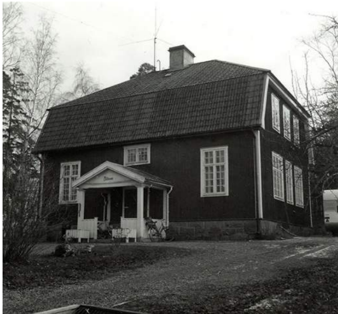
Skjutbaneföreståndarens bostad, logement och skjutbane- expedition för skjutbanan. Ägare och byggherre var Forti- fikationsförvaltningen. Byggår 1911. Arkitekt: Erik Josefsson. Till byggnaden hörde en verkstad för måltaveltillverkning, jordkällare och två små uthus. Foto: Solna bildarkiv. Bild.nr: 202218 05, 1983.
