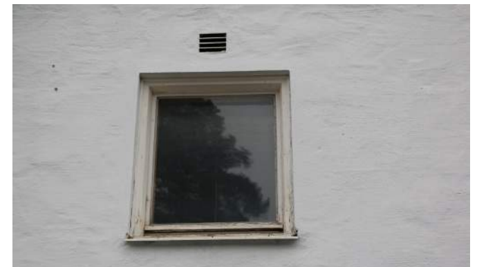
Ursprungliga enluftsfönster av trä.
