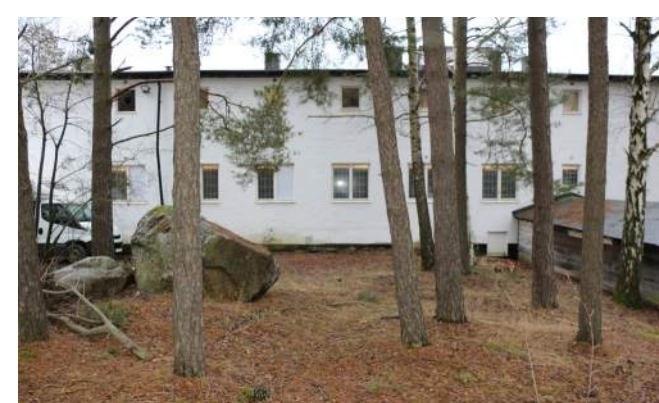
Fasad mot naturmark mot norr.
