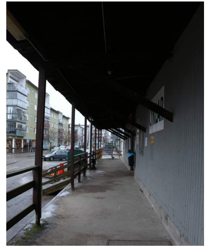
Lastbrygga med stolpar av trä.
