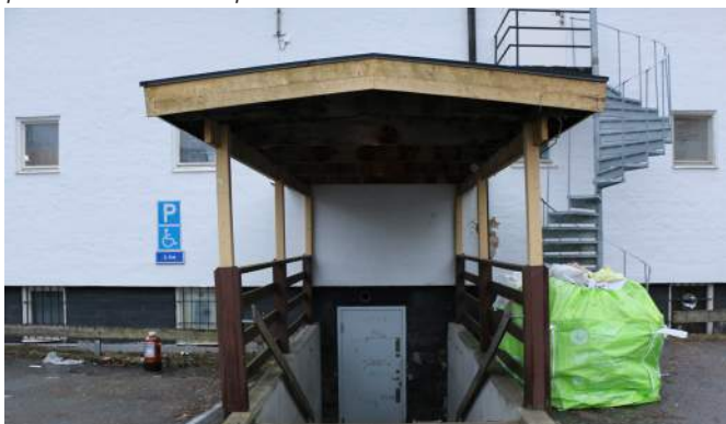
Entré till källarvåning mot norr. Sentida skärmtak.
