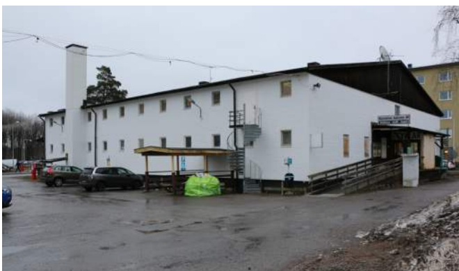
Fasader med skorsten mot norr.
