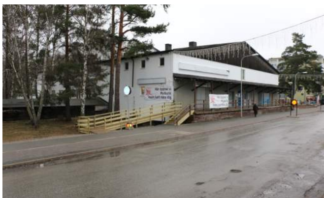
Hus F mot Fridensborgsgatan.
