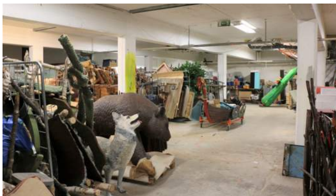
Källare. Delvis ursprunglig öppen plan med betongpelare.
