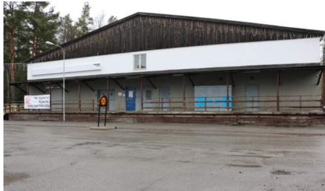
Lastbrygga med skärmtak mot Fridensborgsvägen.
