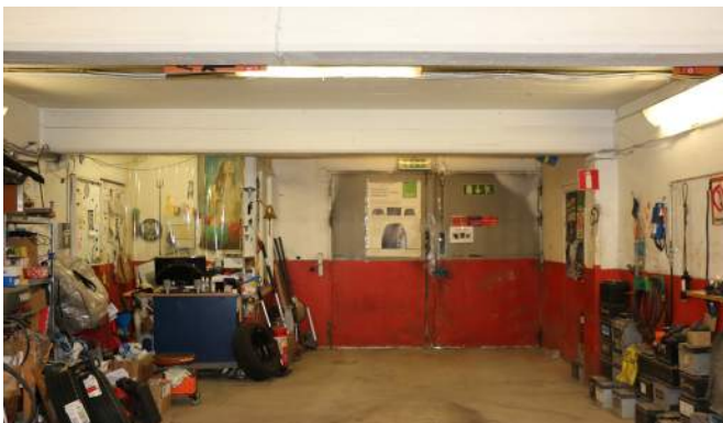
Synliga betongbjälklag i källare.
