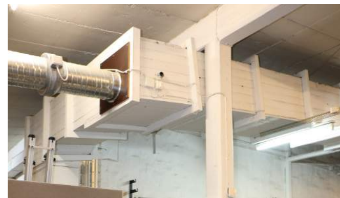
Ventilationskanal av brädor.
