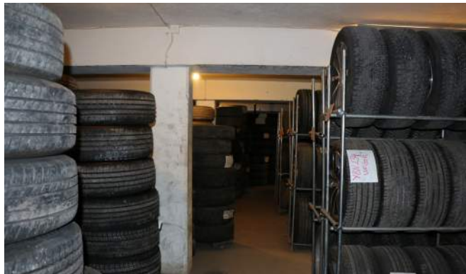
Källare. Rum med gjutna golv, väggar, pelare och tak.
