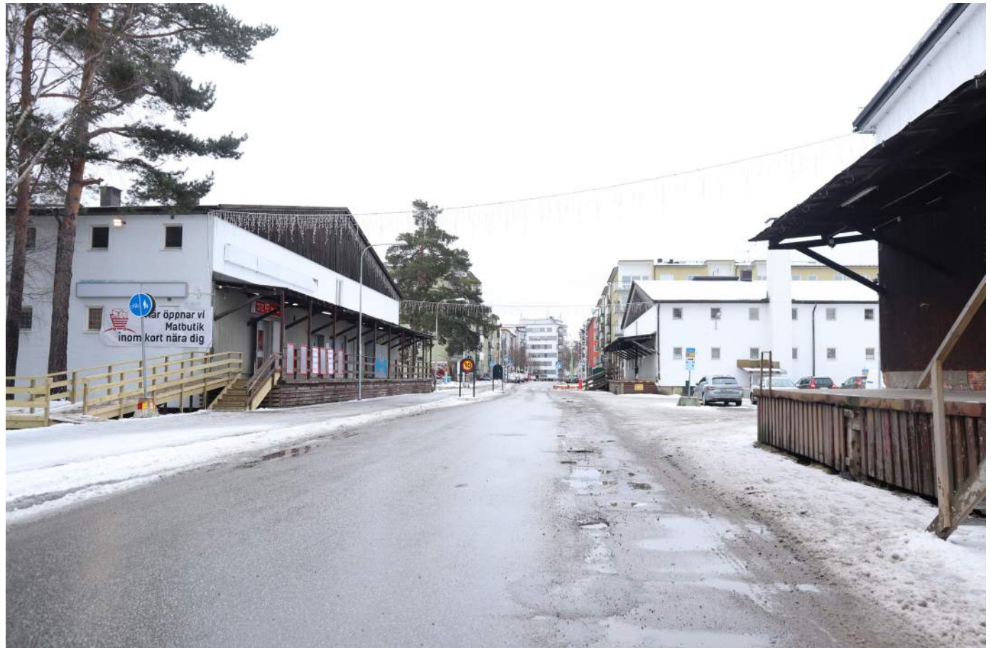
Mobiliseringsförråden vid lokalgatan Fridenborgsvägen från norr.
