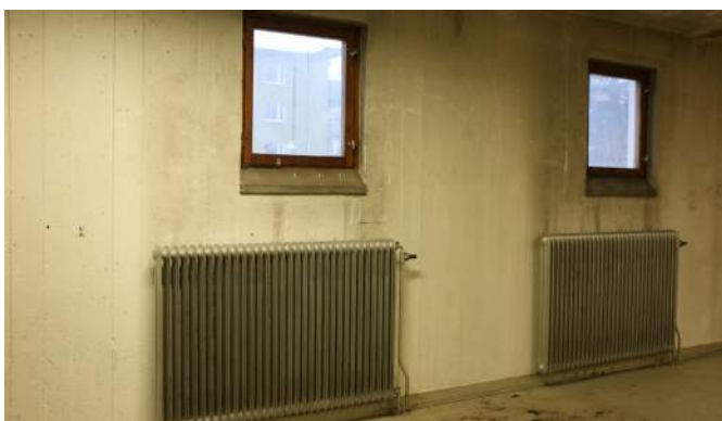
Våning 1 tr. Ursprungliga fönster och radiatorer.
