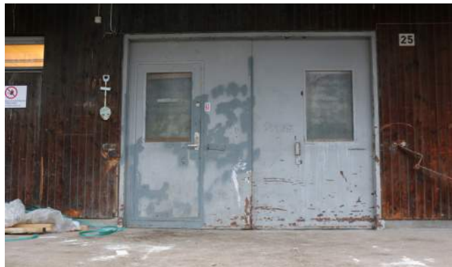
Ursprunglig stålport vid lastbrygga.
