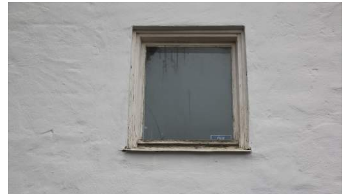
Ursprungliga kopplade ospröjsade fönster av trä.
