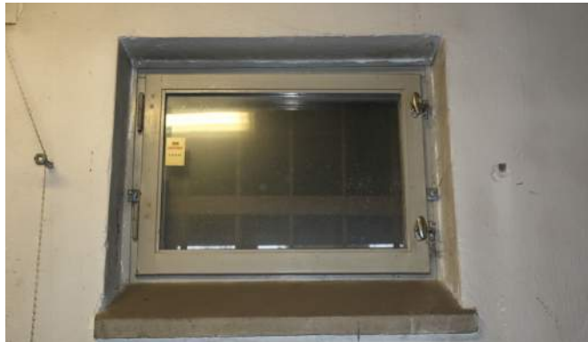
Ursprungliga fönster och fönstervred.
