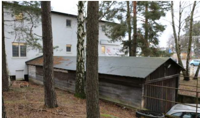
Utbyggt garage/förråd mot norr.
