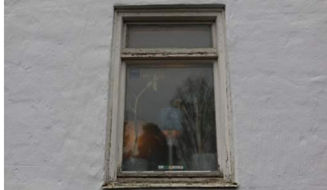
Ursprungliga fönster med tvärpost i gavlar.
