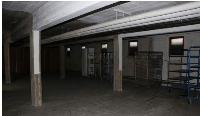
Källare med gjutna golv, brädgjutna tak och pelare.
