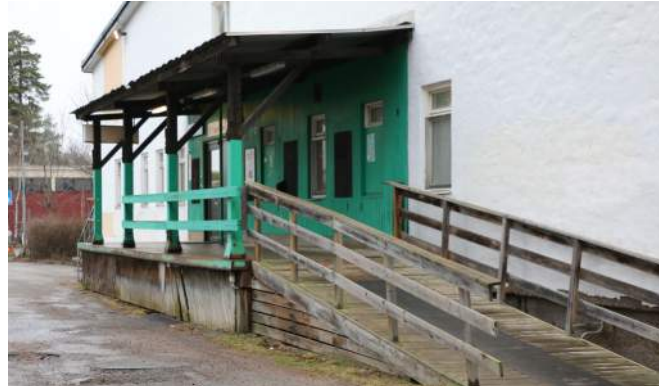
Entré med skärmtak.
