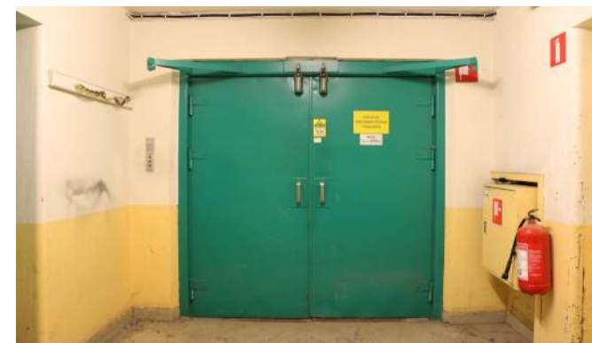
Ursprungliga stålportar till transporthiss.
