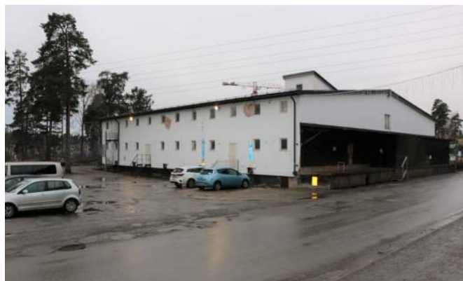
Hus E's lastbrygga mot Fridensborgsvägen.
