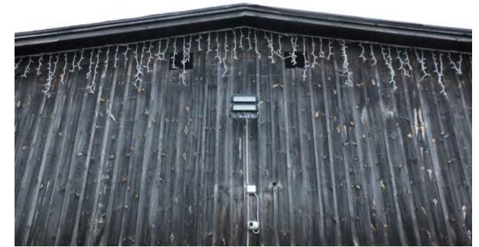
Detalj av laserad locklockpanel i gavelröset.
