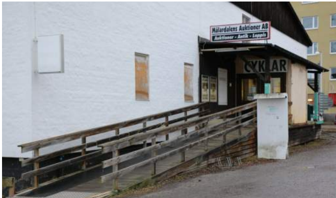
Entré mot söder med ej ursprunglig aluminiumport, kompletterad med ramp.
