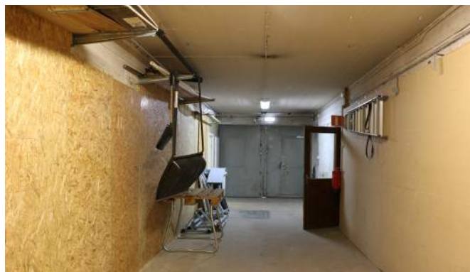
Bv. Mittkorridor mot lastbygga.
