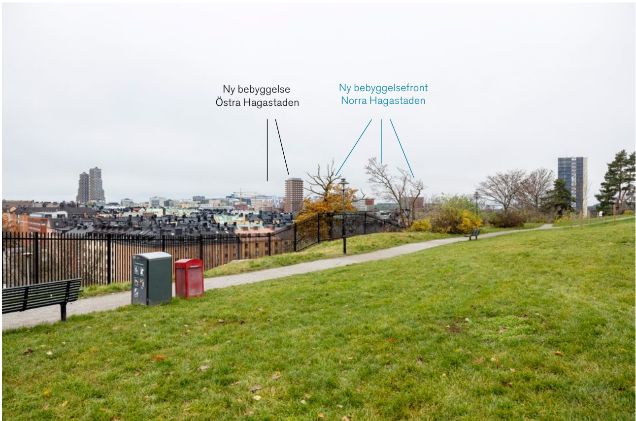
Planförslaget inklusive bebyggelsen i detaljplanen för Östra Hagastaden. Observera att fasaduttrycken på volymerna i planförslaget endast är illustrationer.
