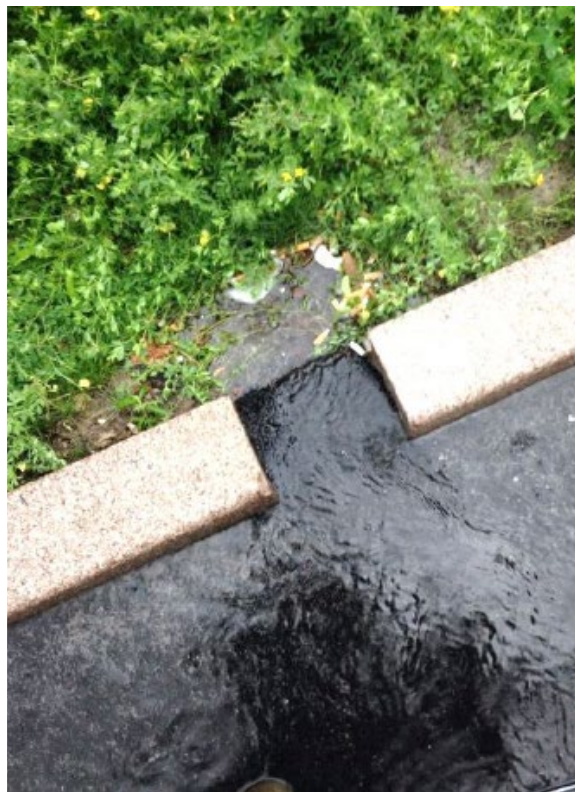
Exempel, nedsänkt regnbädd samt utformning av kantsten för tillrinning av dagvatten till regnbädd, källa Niras.
