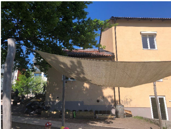
Mönstringen 3, fasad vid Honnörsgatan.
