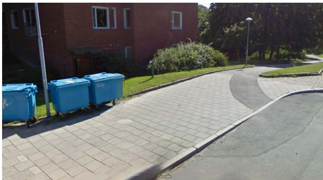
Figur 4-3. GC-väg och källarnedgång vid Kristinelundsvägen 26.
