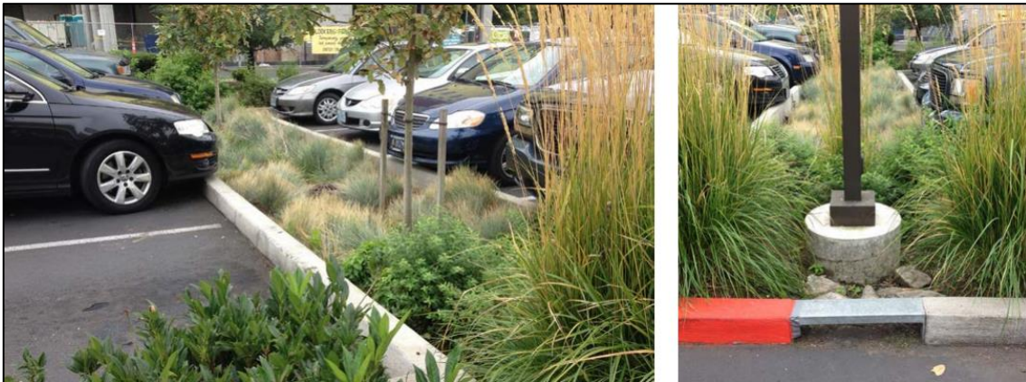
Figur 6-3. Exempelfoto på regnbäddar i gatumiljö där dagvattnet leds in i regnbädden via öppningar i kantstenen (Stockholm Vatten och Avfall, 2022b).
