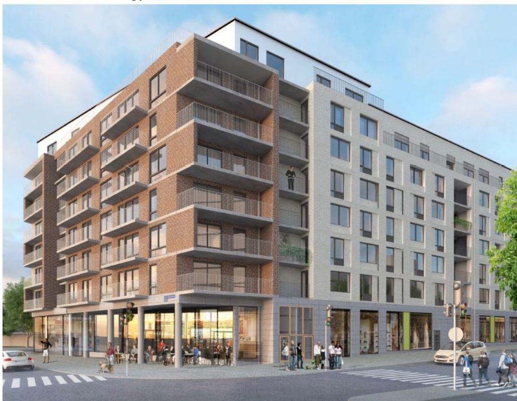
Vy från Gränsgatan/Råsundavägen. Transparent sockelvåning med natursten som fasadmateriäl mot gata. Kvarterets huvudfasader, mot Råsundavägen och Gränsgatan (sydväst) utgörs av tegel. (ÅWL arkitekter)
