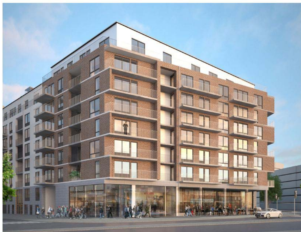
Vy Gränsgatan. Transparent sockelvåning som binds samman genom en enhetlig sockelvåning i natursten. Kvarterets huvudfasader, mot Råsundavägen och Gränsgatan (sydväst) utgörs av tegel. (ÅWL arkitekter)
