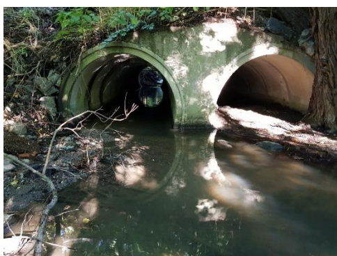
Figur 10. Befintligt vandringshinder: kulvert under Järvavägen
