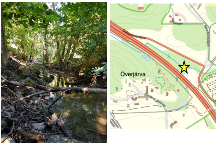
Figur 9. Befintlig strömmande sträcka i behov av förbättringsåtgärd i Igelbäcken
