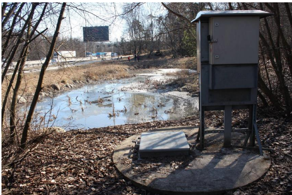
Figur 9. Dagvattendamm med pumpstation.
