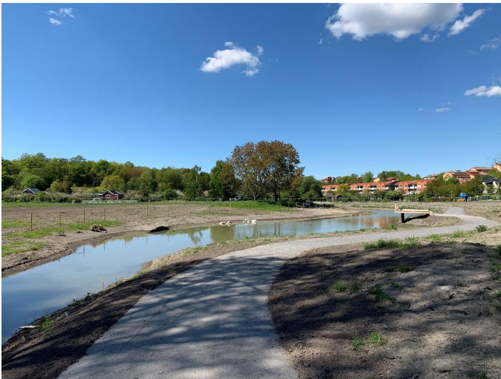
Figur 22: Sedimentationsdammen vid Pumphusängen i Bergshamra, Solna.
