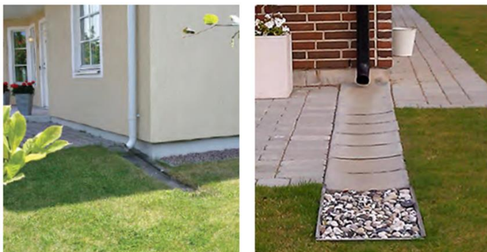
Figur 23. Rinnplattor kan användas för att leda bort regnvatten från stuprör till gräsmattan eller diken (Källa: NSVA).
