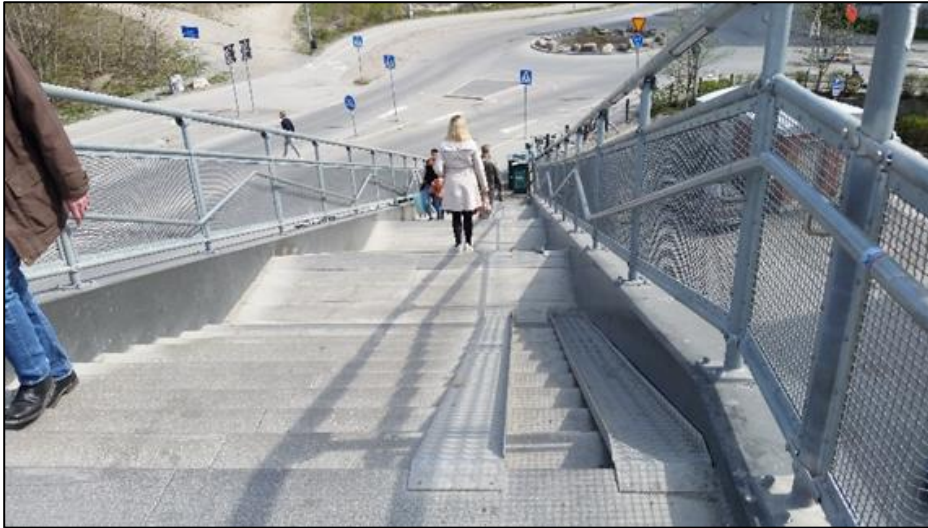
Figur 3-1 Trappa från Målbron till Gårdsvägen-Kolonnvägen (Foto WSP)
