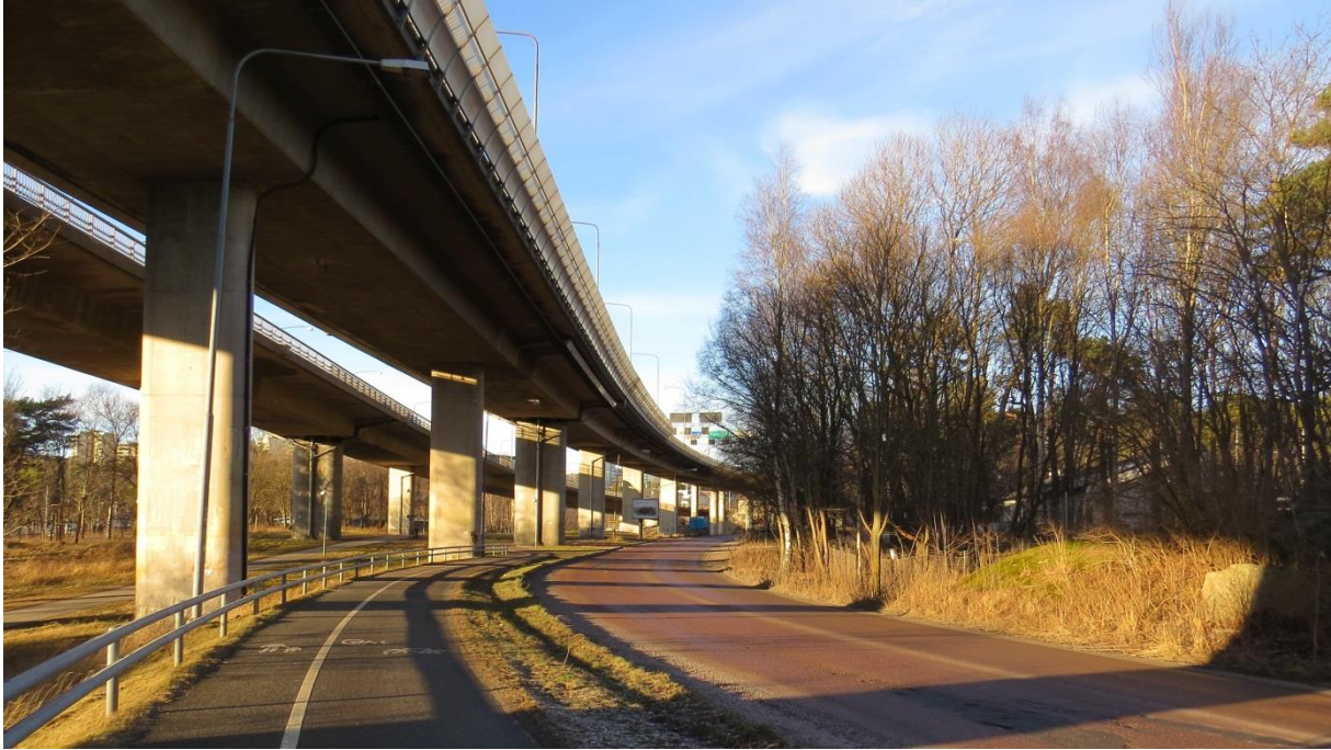
Figur 17. Essingeledens viadukt, Ekelundsvägen och till höger i bild delyta 1 i inventeringsområdet. Det finns ett samband i grönstrukturen och en viss spridningsmöjlighet för växter och djur under Essingeledens viadukt mellan Ekelundsområdet och inventeringsområdet i Karlbergsområdet.
