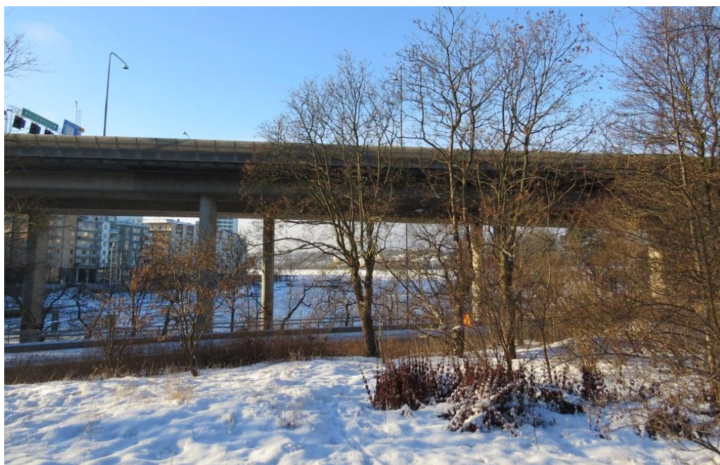
Figur 7. Delyta 1. Från den öppna ytan ser man över Ekelundsvägen och under Essingeleden mot Ulvsundasjön. Bakom Ekelundsvägen skymtar trädtoppar från strandpromenaden.
