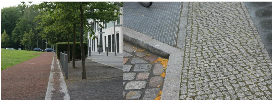
Figur 18 – Exempel på permeabla markbeläggningar, här vid gång- och cykelstråk (Bild: Sweco).
