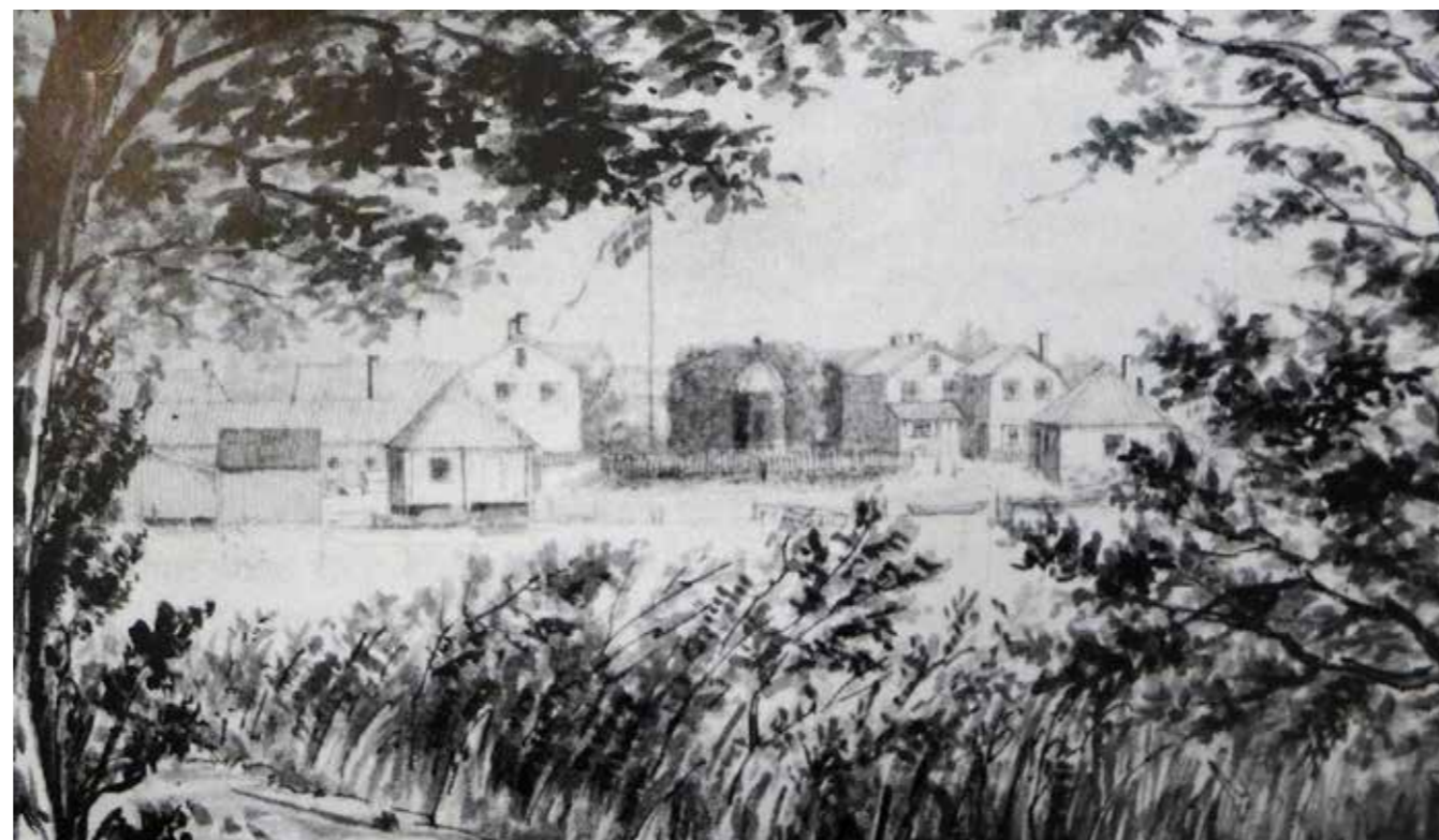
En teckning av konstnären och militären Alexander Clemens Wetterling från 1828 visar att det gamla brygghuset och det före detta pumphuset hade toppiga tälttak i karolinsk stil, liknande Norrtulls tullhus. De flankerar varandra som två symmetriskt placerade paviljonger vid stranden. Det före detta pumphuset står till hälften på pålar ute i vattnet.
