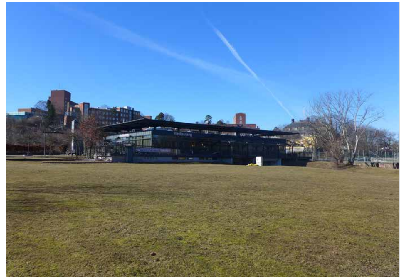
Haga Forum utgör den mot väster närmast anslutande bebyggelsen. Byggnaden uppfördes på 1960-talet. 2016-03-16.
