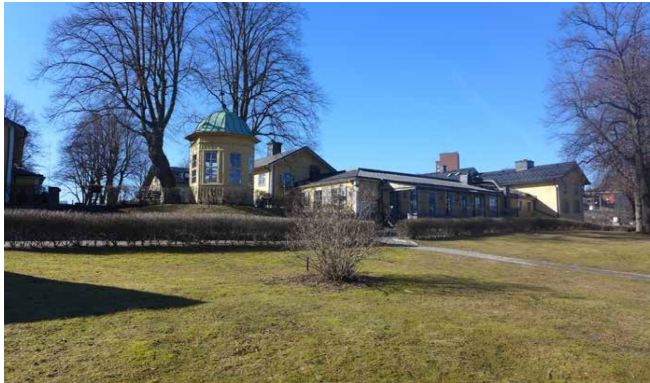
Vy över anläggningen från slutningen ned mot Brunnsviken. Lusthuset bildar ett tydligt fondmotiv. 2016-03-16.
