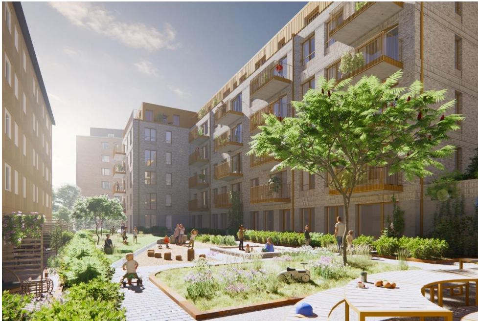
Vy från den överbyggda innergården mellan de nya och de befintliga bostadsbusen. White arkitekter
