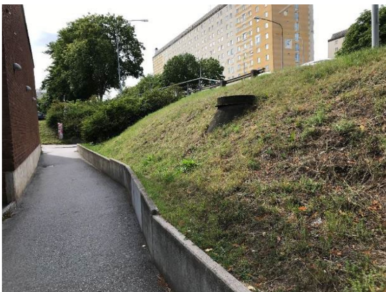
Figur 7.3. Tunneln sedd från gångväg mot Solna centrum. Till vänster är kvarteret Turkosen. Gångvägen ligger inom kvartersmark.
