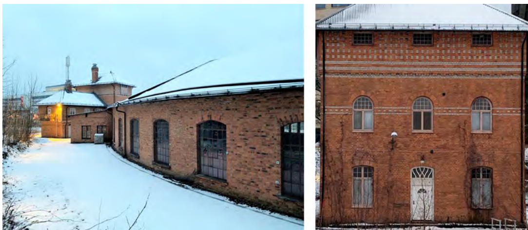
Fig 55. T.h. Lokstallet har ett stort småspröjsat stickbågefönster i gjutjärn för varje lokuppställningsplats. Tv: Vattentornets fasad i rött tegel med dekorativa band och rutnönster i ljust tegel.
