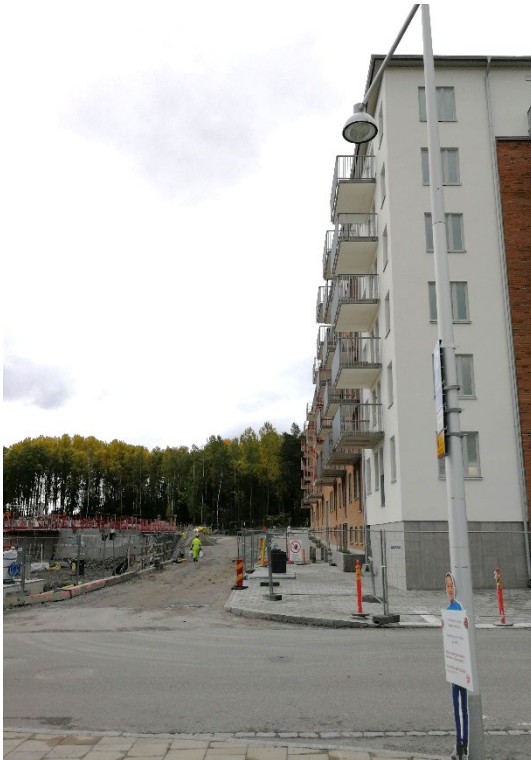
2. Vy mot sydost med aktuellt planområde i bakgrunden, byggnad till höger inom Pyrolan 2. Pyrolan 1 här under tidigt byggskede.
