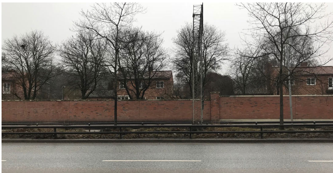
Figur 6. Vy från fastighetsgräns som angränsar till Solnavägen. I bakgrunden syns både bostadsbyggelse och mur uppförda i tegel.
