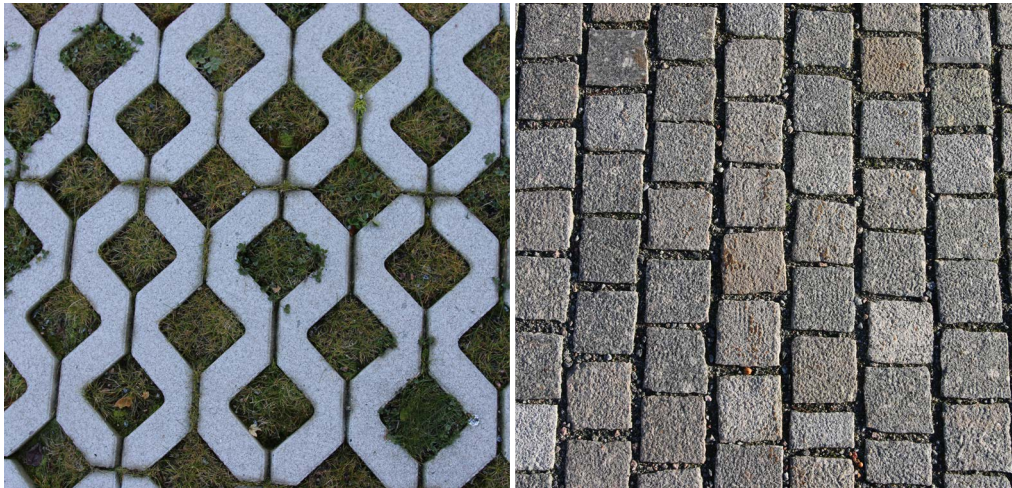
Exempel på genomsläpplig beläggning i Järvastaden (foto: Solna stad).
