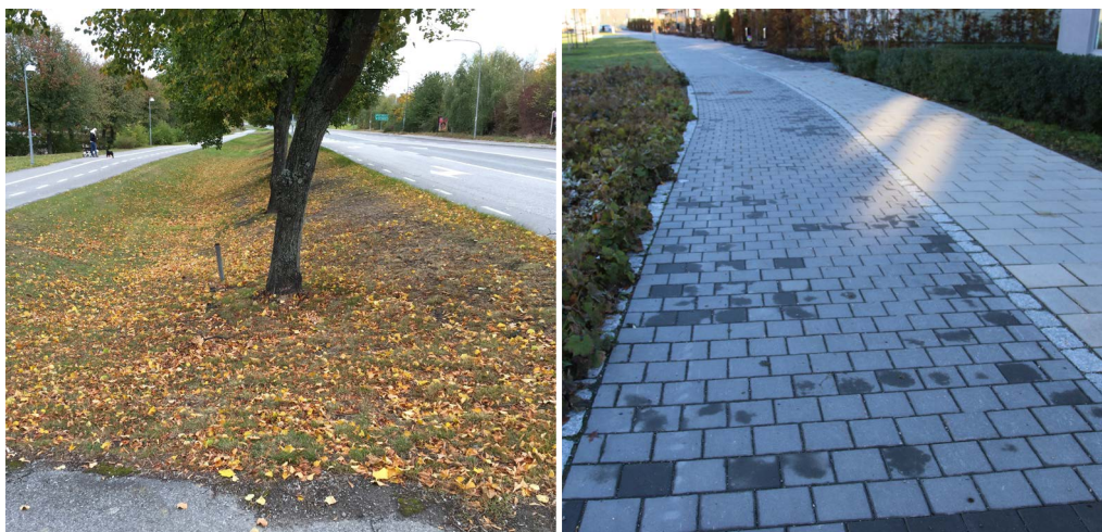
Svackdike Ekelundsvägen (foto: Solna stad). Infiltration grönyta Järvastaden (foto: Solna stad).
