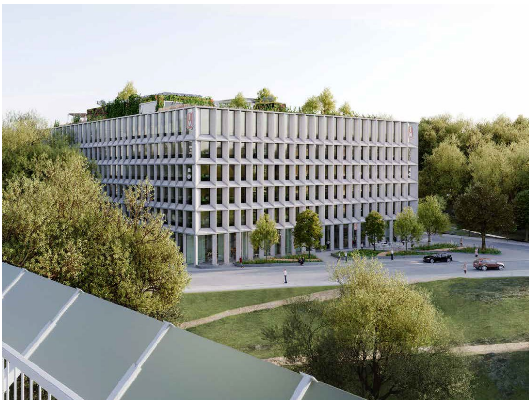
Föreslagen byggnad med entrétorg, vy från Essingeleden (bild: Wingårdhs)
