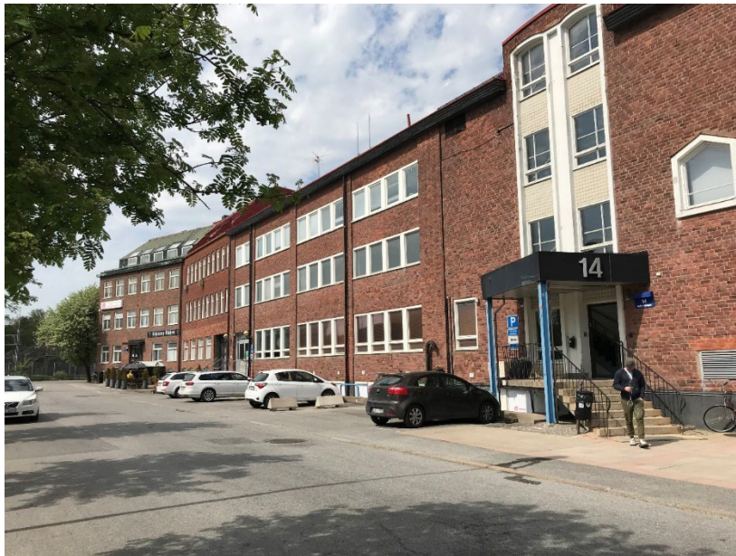
Befintlig bebyggelse vid Åldermansvägen idag.
