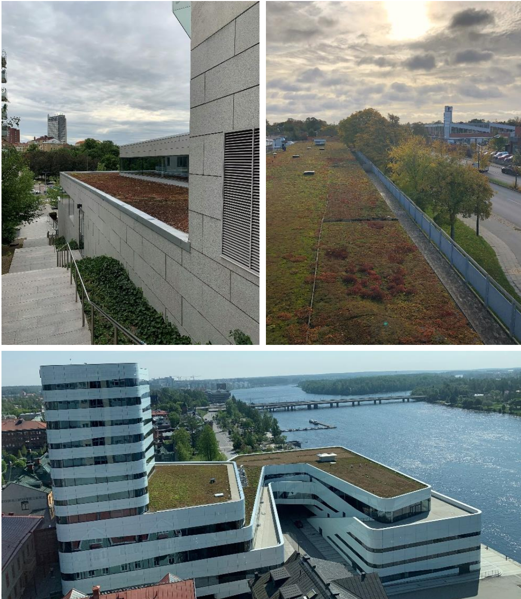
Figur 22. Sedumtak kan anläggas på bostadshus och som tak över cykelparkering eller sophus (Foto: Bjerking)
