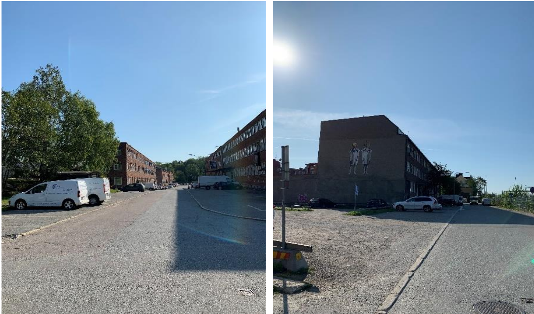
Figur 10. Fotografier från korsningen Gelbgjutarevägen t.v. och Åldermansvägen t.h. (Foto Bjerking, 2019).
